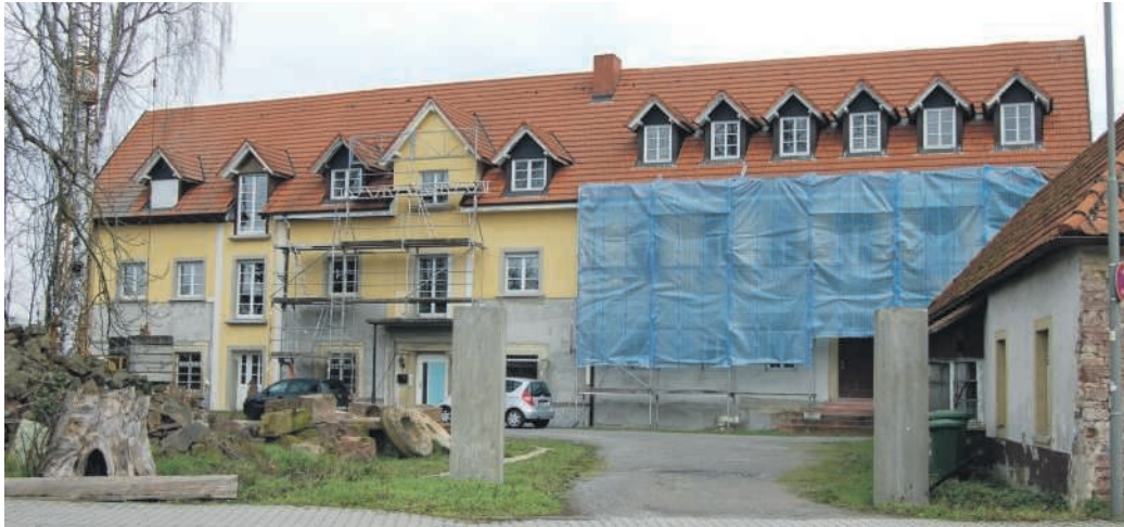
Das historische Mühlengebäude, an der Zufahrt zum Bahnhof Wiesloch-Walldorf gelegen, wandelt sich seit Jahren in ein Wohnhaus.
